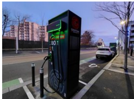
Une station express rue de la gare
