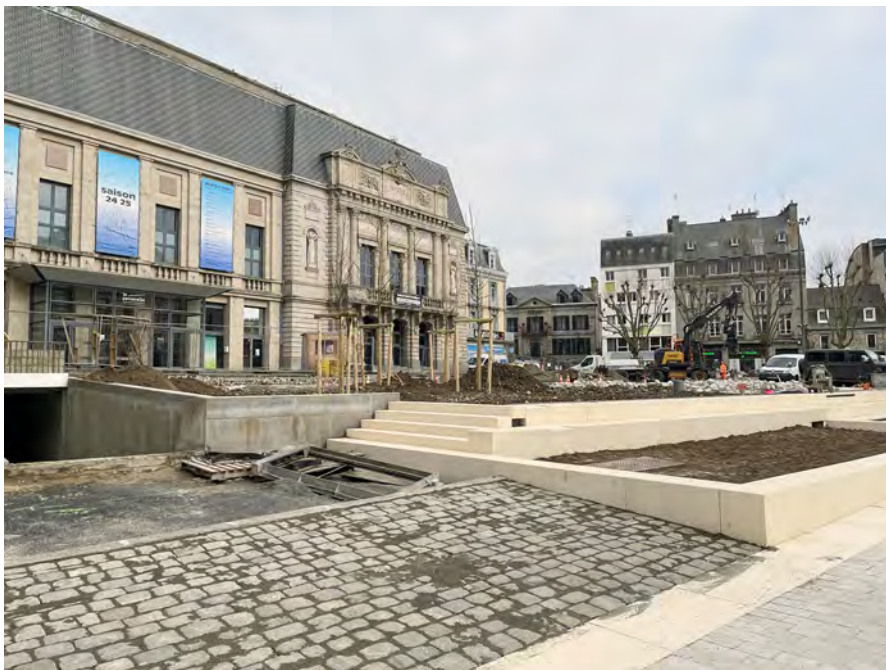
Chantier place de la Résistance
